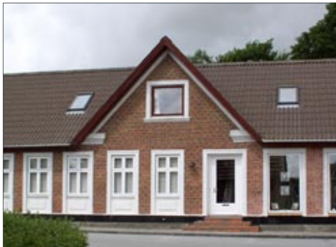
Tidl. købmandforretning i stationsbystil med profilindfatninger og prydfelter.
